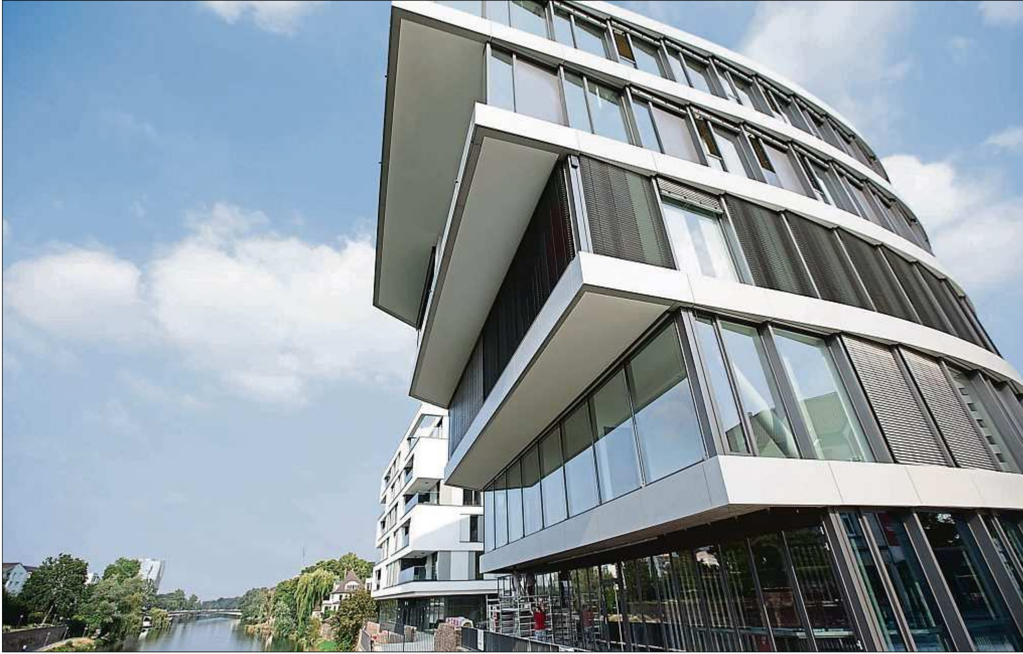
Die Auskragung des Neubaus zur Donau hin.
