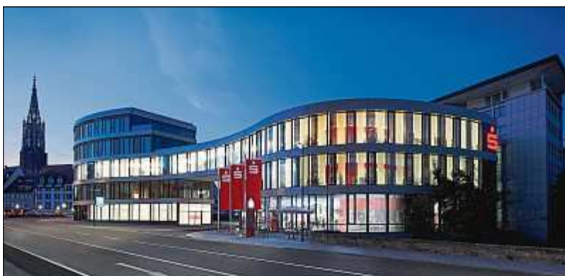
Das neue Brückenhaus der Sparkasse Neu-Ulm.
